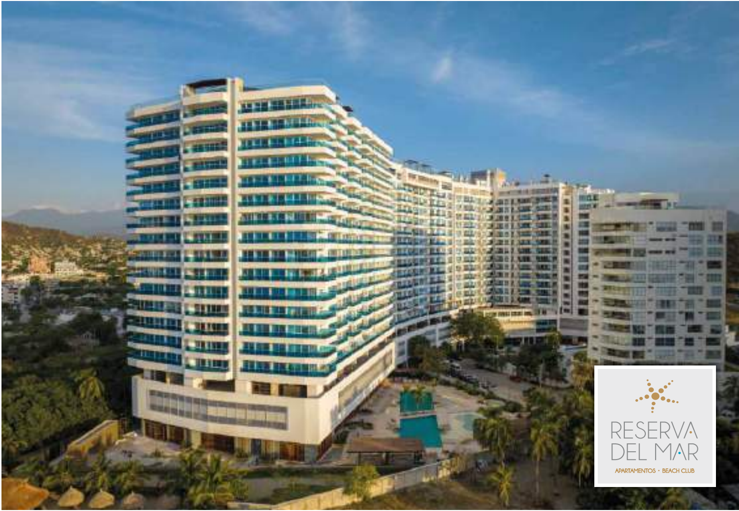
Ubicación: Calle 22 No. 1-67 Playa Salguero, Santa Marta Unidades de vivienda: 591 Pisos de altura: 18 y 19 Estado: Finalizado en 2023.
