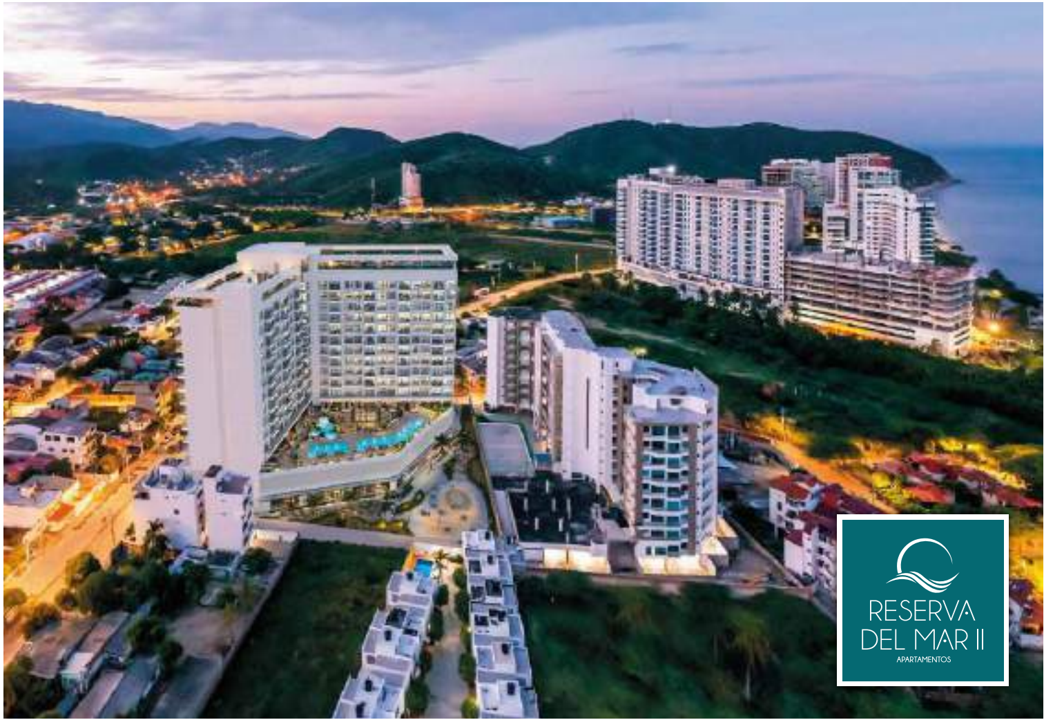
Ubicación: Avenida Tamacá con calle 21, Rodadero Sur, Santa Marta Unidades de vivienda: 431 Pisos de altura: 15 Estado: En construcción.
